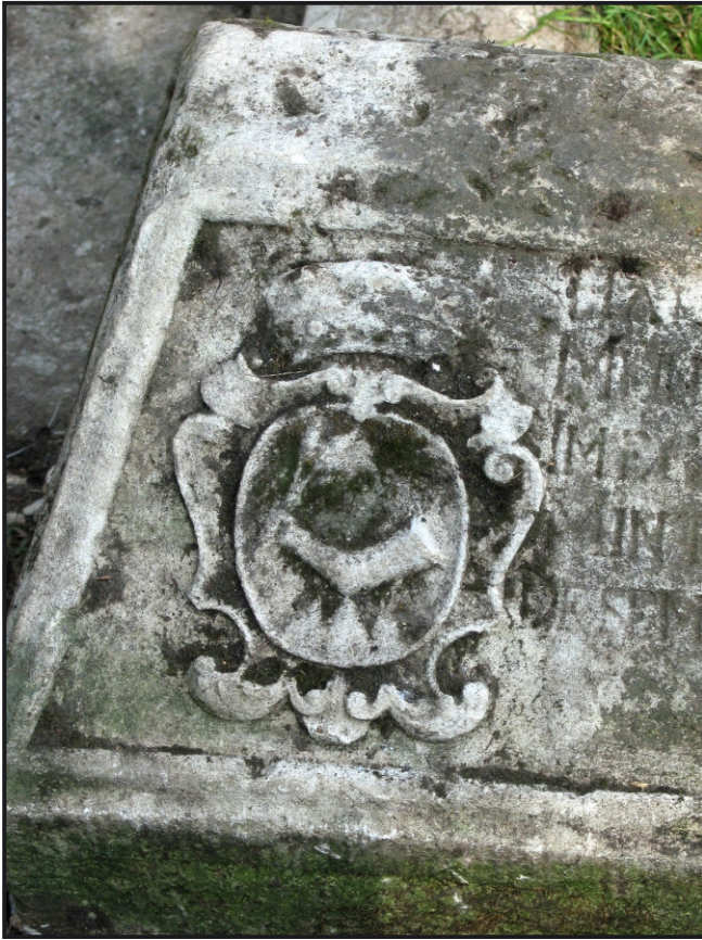
B. Helyreállítás közben
