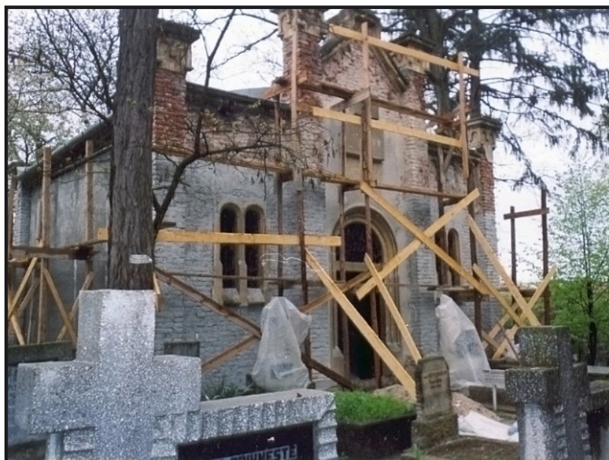
B. Helyreállítás közben
